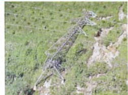
岩知志線 鉄塔倒壊現場 (勇払郡むかわ町)
