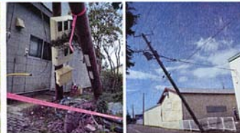
電柱折損・傾斜現場 (沙流郡日高町)
