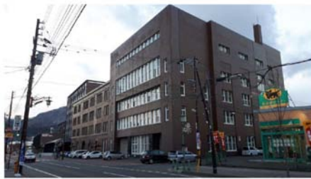
ニチロビル(函館市大手町5-10)
